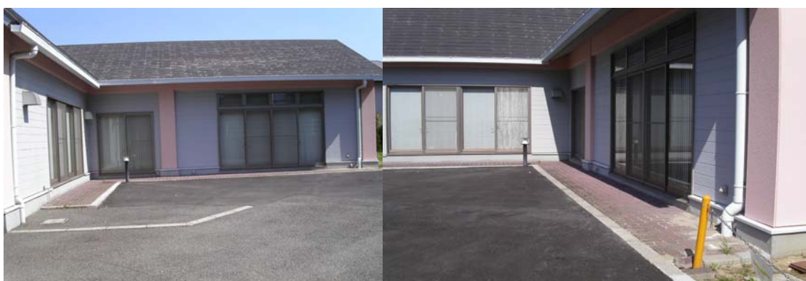
② 駐車場の車止め新設
