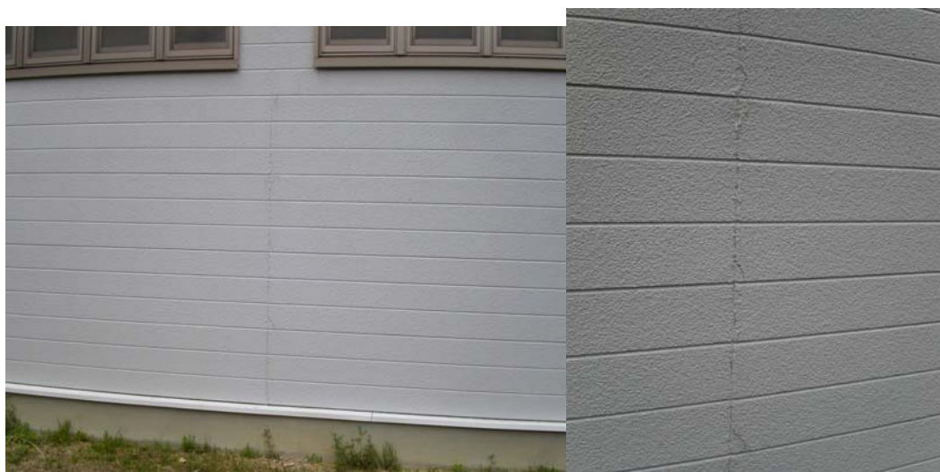
③ 外壁防水・塗装箇所（大会議室）
