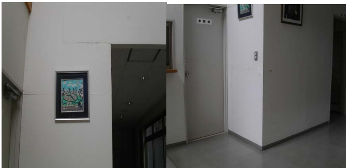
① 集会所玄関ホールのクロス張り
